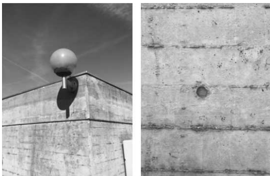
Façades en béton banché
