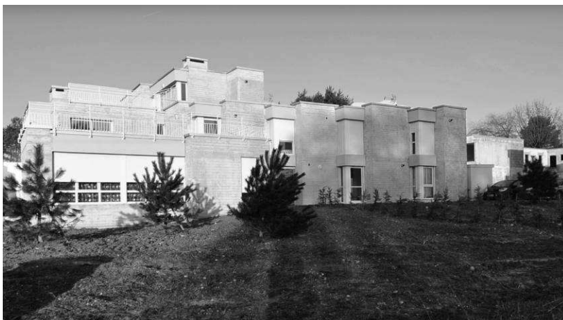
Façades en béton banché
