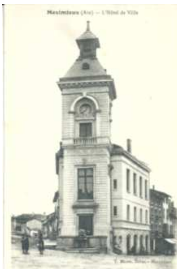
Hôtel de ville de Meximieux après rénovation totale de 1898/1899
