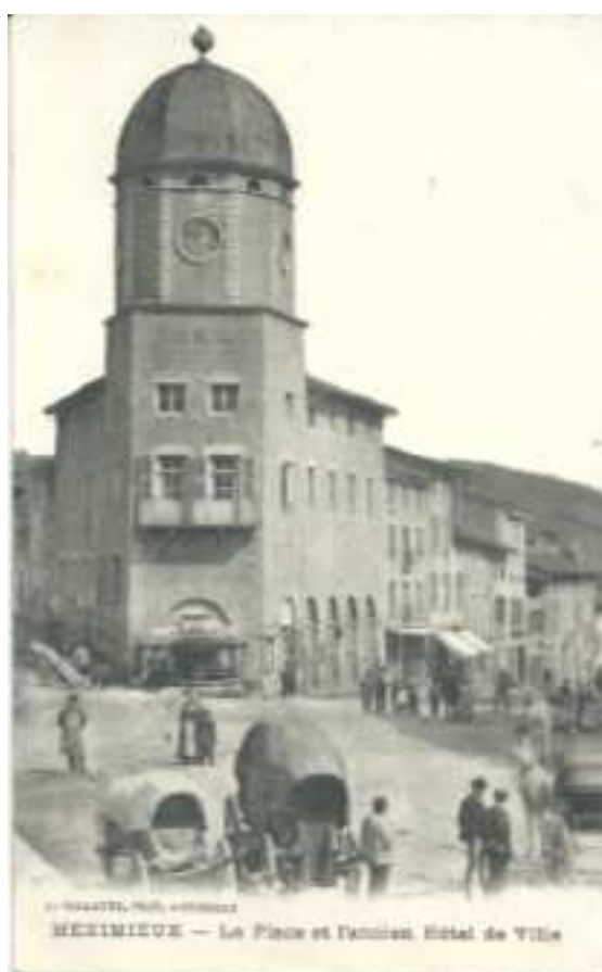
Hôtel de ville de Meximieux avant travaux de 1888
